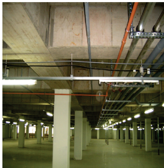
Đường ống ở Graywater Treating Facility
